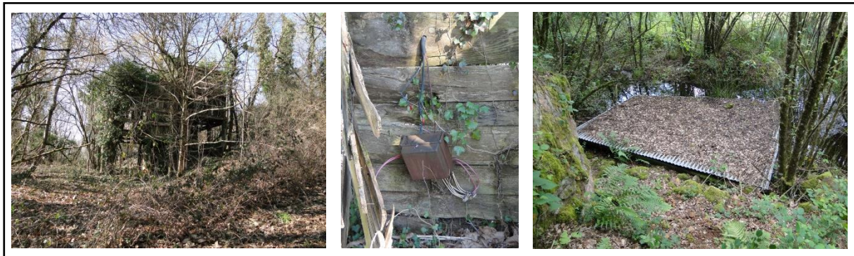
Figure 39 : Vestiges de l'exploitation de la carrière de Montoume (2015).
