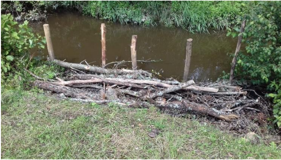
Figure 47 : Photographie du chantier ATE Rochechouart de juillet 2021
