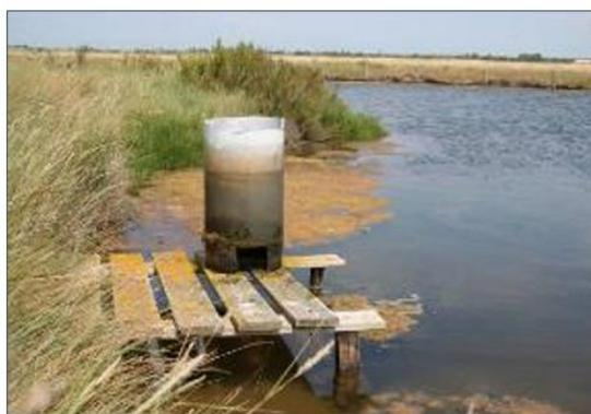
**Figure 4 : Exemple d'une « surverse » avec un ponton.**
