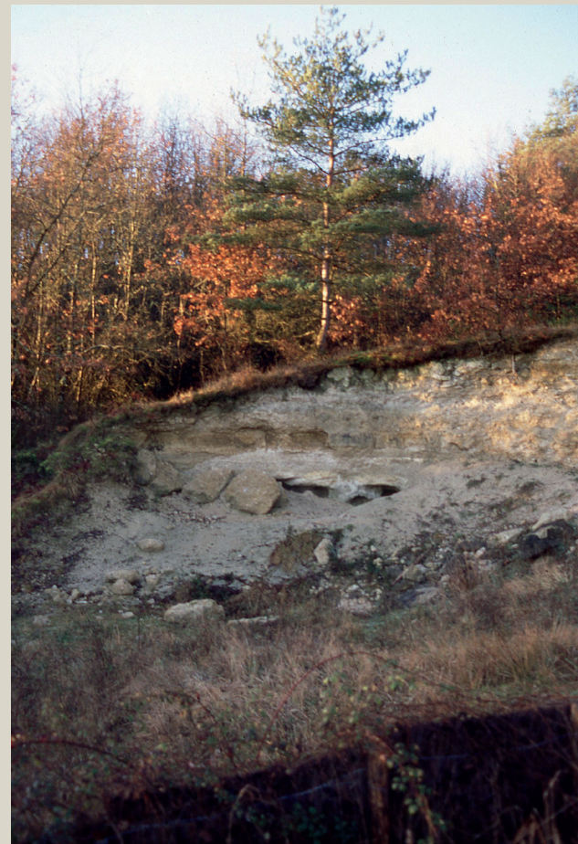
Front de taille avec démantèlement des niveaux durs (grès, calcaires) et glissement des sables - © Didier Poncet
