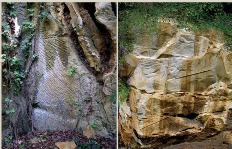
À gauche : Traces d'extraction au pic de tailleur de pierre - © Didier Poncet À droite : Trous de foration réalisés à l'aide d'un perforateur pneumatique © Didier Poncet
