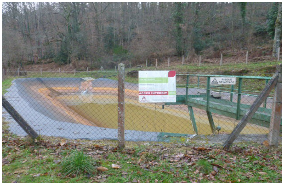
Bassin de réception des eaux d'exhaure
