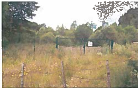
Portail d’accès au stockage de résidus de traitement dans la MCO
