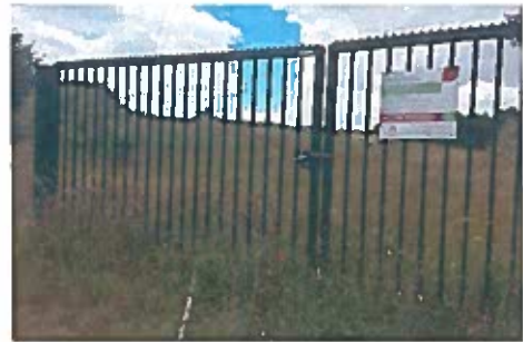
Portail d’accès au stockage de résidus de traitement dans les stalles de lixiviation
