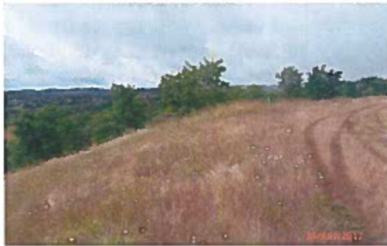
Digue de Lavaugrasse – crête en partie Sud
