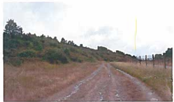
Digue de Lavaugrasse – pied en partie Sud
