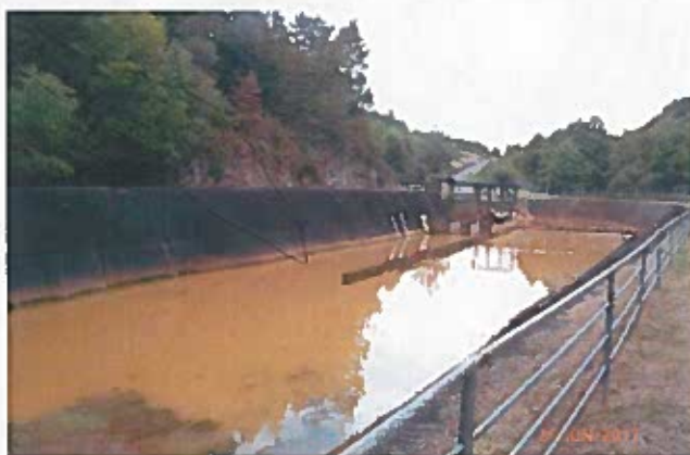
Bassin du Vieux Moulin – collecte des eaux de la partie Sud du SIB et décantation (première phase de traitement)
