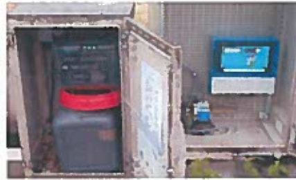
Point de prélèvement avant rejet dans la Gartempe SIB2 (débitmètre et préleveur)
