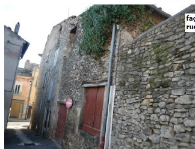
îlot 1a, rue de la Bourgade, parcelle C 360
