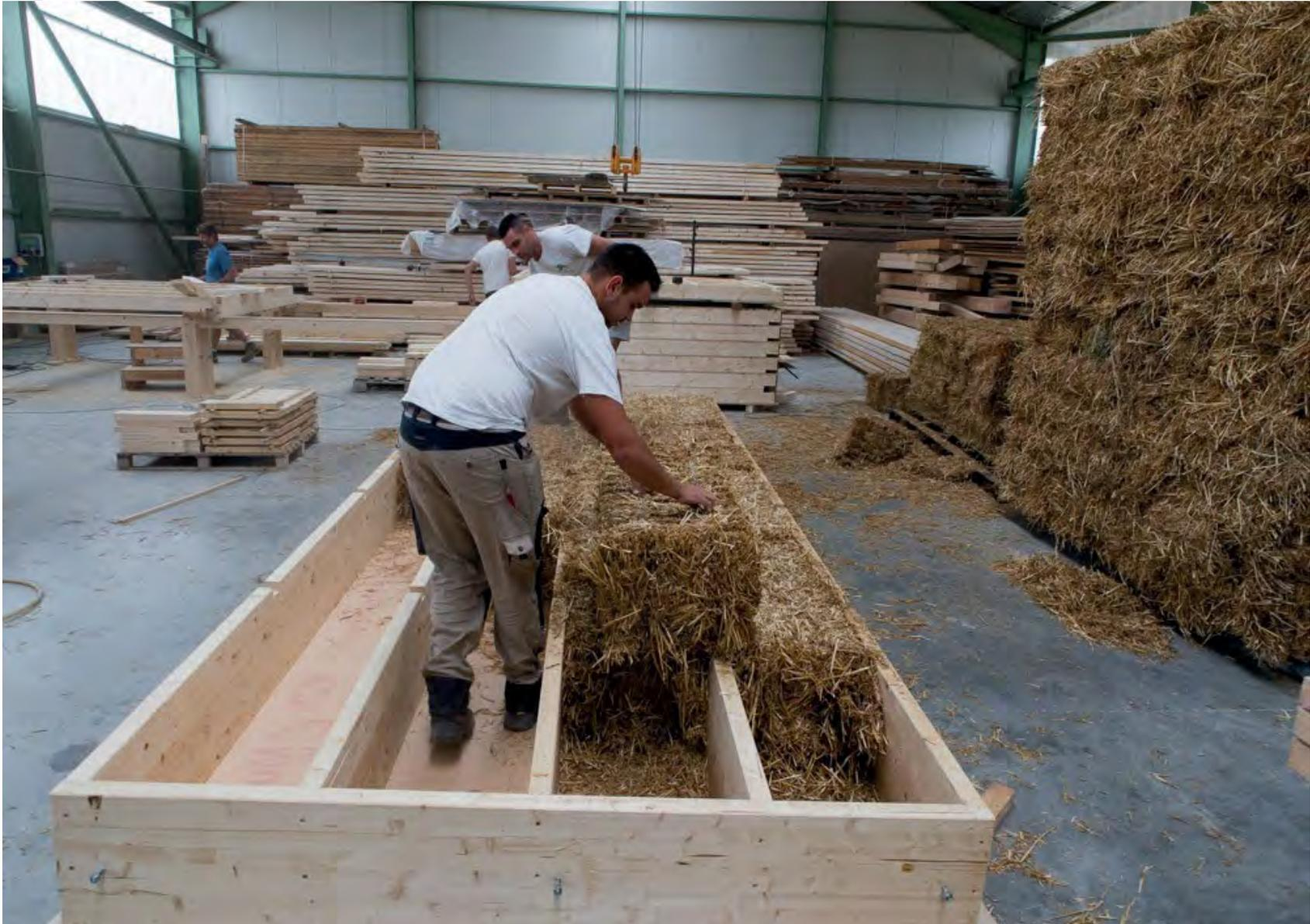
Mise en oeuvre de la paille isolante entre montants
