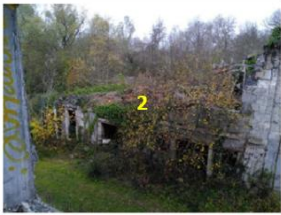
Bâtiment n°2 (en PSE)
