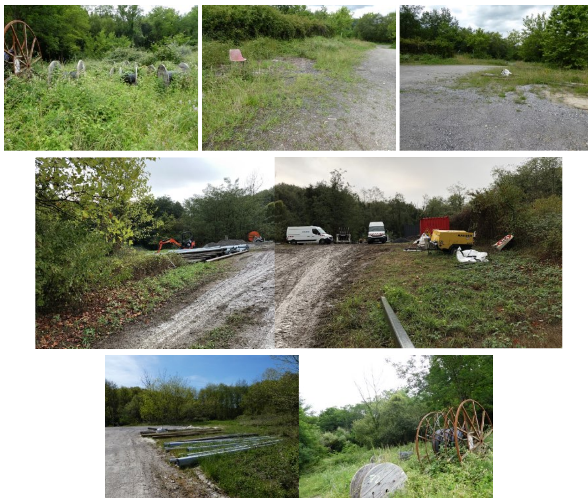
Emplacement du futur poste de sectionnement
