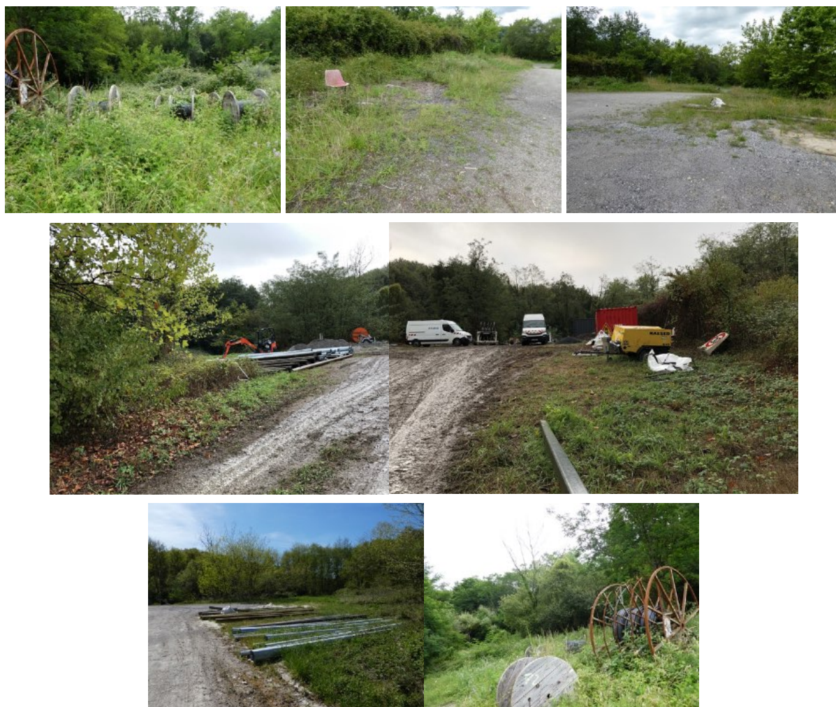
Emplacement du futur poste de sectionnement
