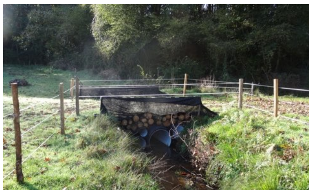
Figure 12. Exemple de franchissement par gaines
