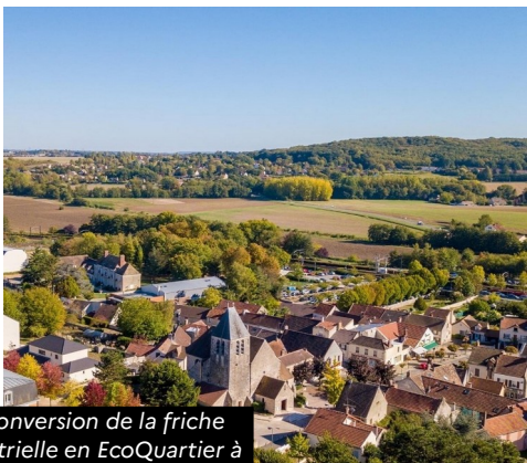
Reconversion de la friche ferroviaire en EcoQuartier à Plancoët (22)
