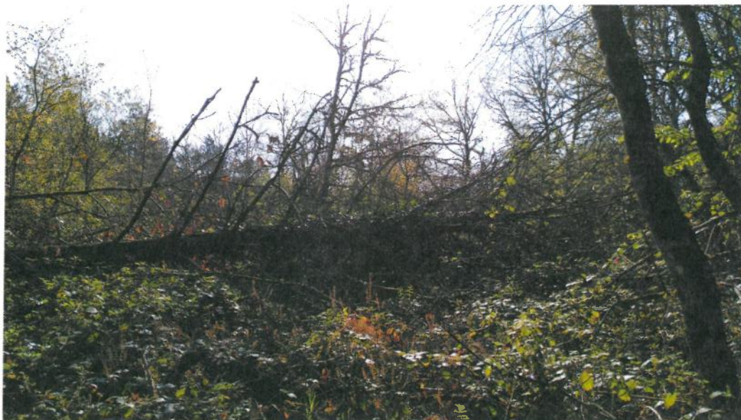
Figure 4: Chute d'arbre contre la clôture au niveau de la verse à stériles au Sud-Est du site
