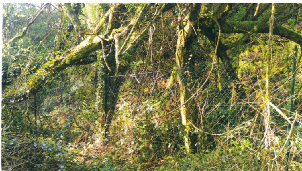
Figure 5: Chute d'arbre contre la clôture côté RD 130, à l'Ouest du site
