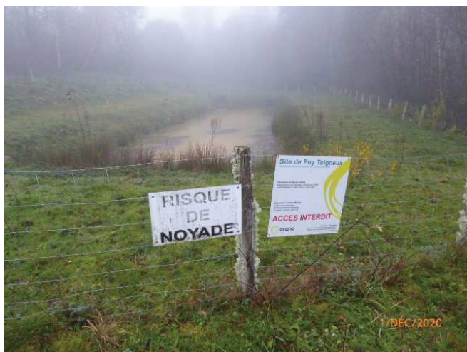
Figure 2 : bassin de récupération des eaux minières
