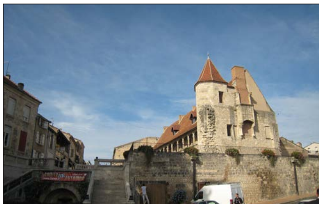
Aile nord du château
