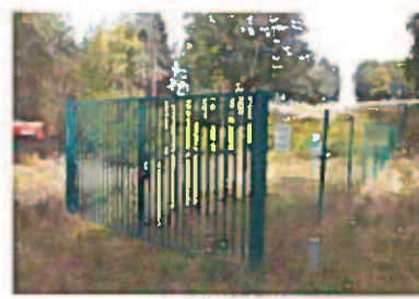
Clôture au Nord de la MCO
