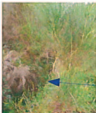
Fossé le long de la piste canalisant les eaux
