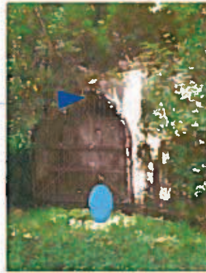
Entrée du travers-banc N-109 obturée et équipée de 2 drains
