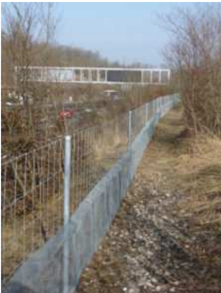
Exemple de clôture à petite faune (source : http://www.karch-ge.ch ).
