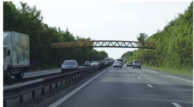
Figure 36. Passerelle pour piétons sur l'A33 (Source : Cerema - Est)
