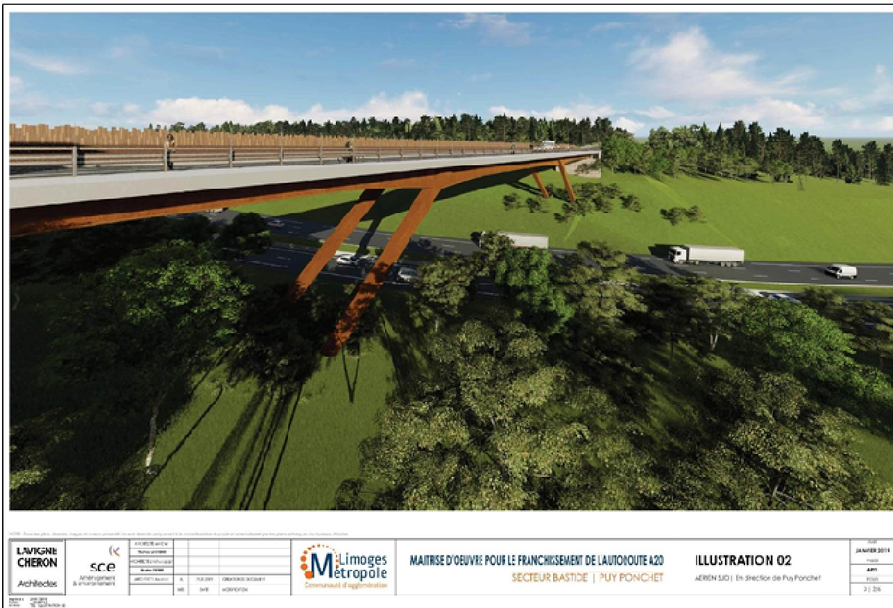
Figure 11 : Illustration de l'ouvrage de franchissement - pont à béquilles (dossier PRO)
