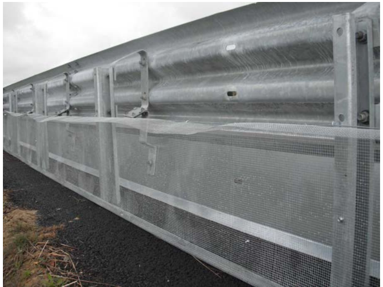
Exemple de clôture posée sur glissière
