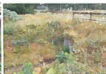
Fossé busé pour la traversée de la piste avant rejet dans la Couze
