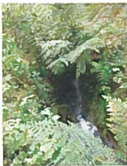
Exutoire des eaux du canal de dérivation dans le fossé
