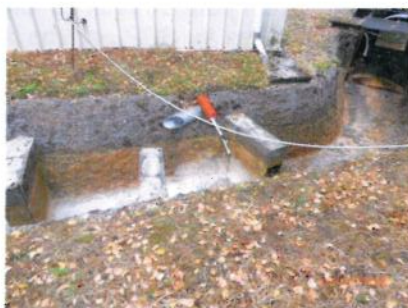
Figure 7: décanteur et hauteur des boues
