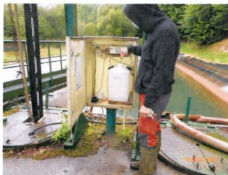
Figure 6: Préleveur automatique des eaux du bassin de réception et regards des pompes de relevage
