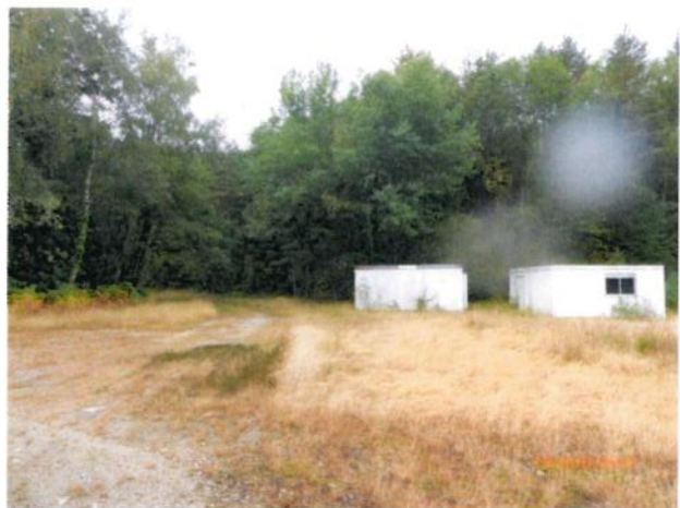
Figure 9: Bâtis légers du SDIS implantés sur le carreau minier
