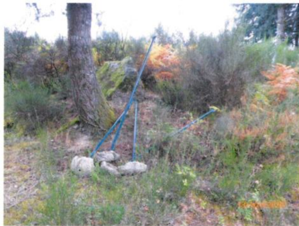
Figure 10: Vol de clôture, grillages dégrafés et poteaux descellés posés à proximité
