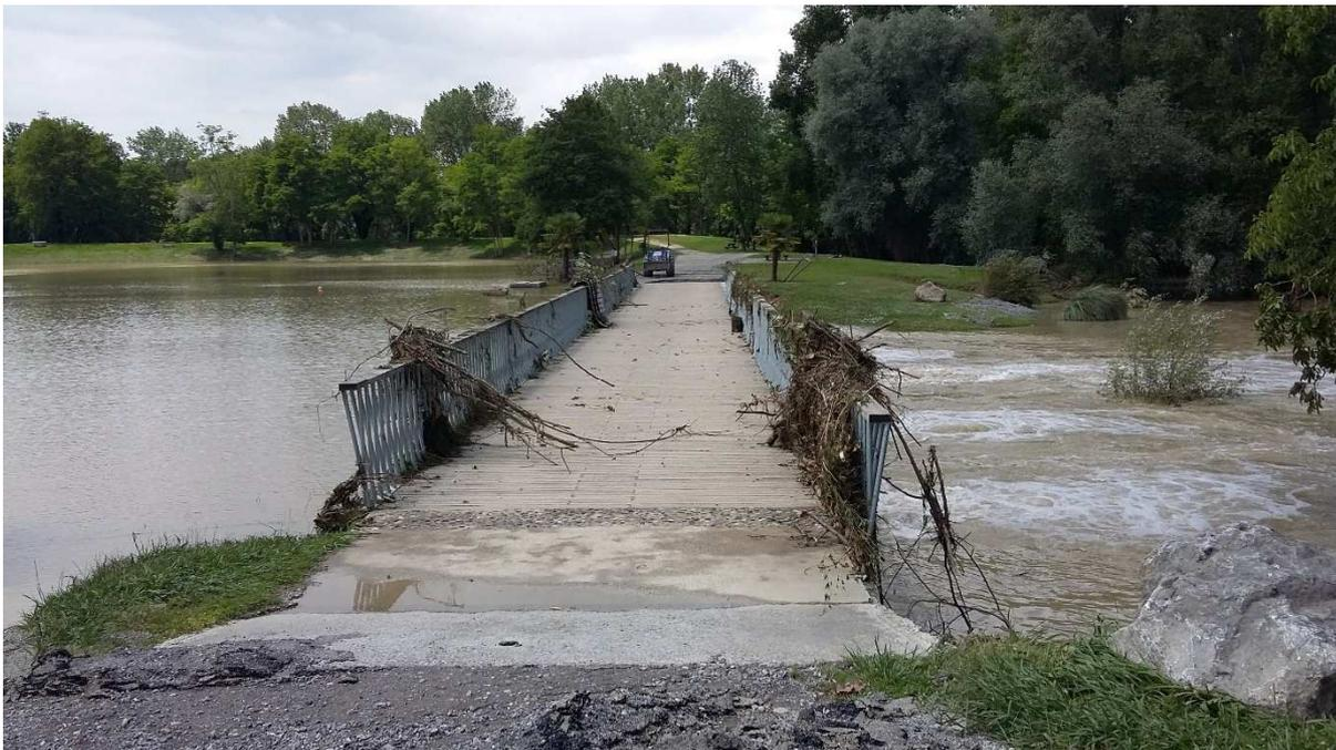
Embâcles s'accumulant sur les garde-corps et sous l'ouvrage (2018)
