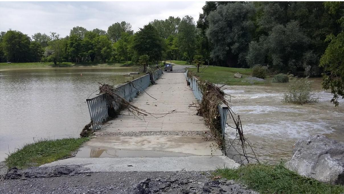
Embâcles s'accumulant sur les garde-corps et sous l'ouvrage (2018)
