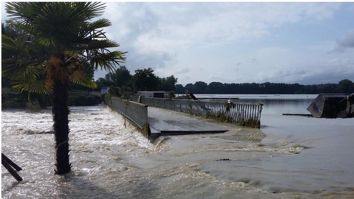
Immersion de la passerelle nouvellement refaite et embâcles sur l'ouvrage (2018)
