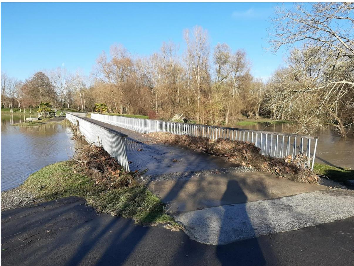
Embâcles accumulés sur les garde-corps et sous l'ouvrage (janvier 2022)
