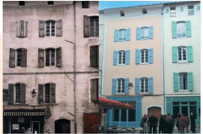
Figure 4: Immeuble Ribbes-Blanc avant/après - source : DDT 04 - Service Aménagement Urbain et Habitat (SAUH)
