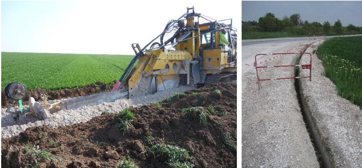
Exemple de tranchée réalisée (Source : TotalEnergies)
