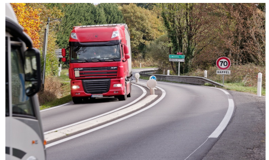
Le profil actuel de la RN147 contraint à limiter la vitesse sur plusieurs secteurs DREAL Nouvelle-Aquitaine /Thierry Degen)
