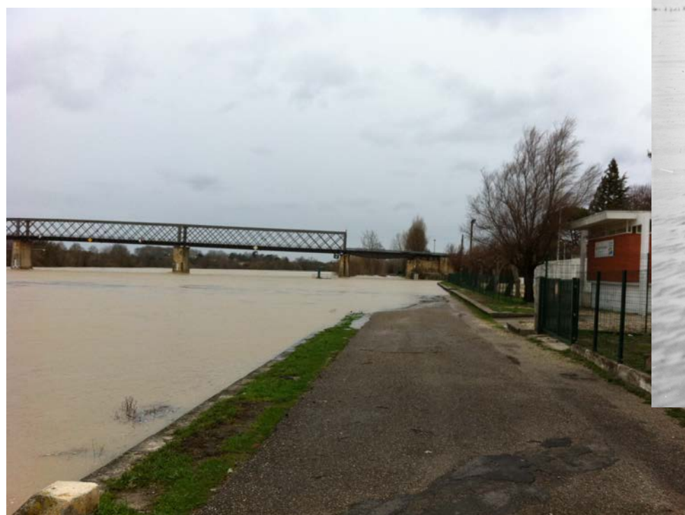
Crue de Janvier 2014 : Vue des abords de la station de Cadillac
