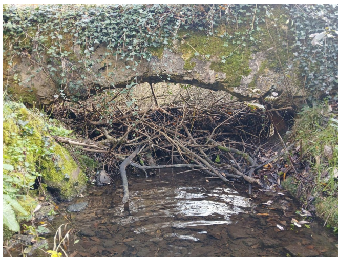
Barrage en appui du petit pont du canal usinier le 03/12/24
