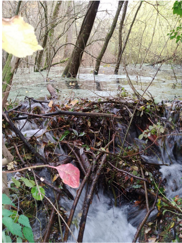
Photo du 3eme barrage Hauteur chute Environ 0,70m
