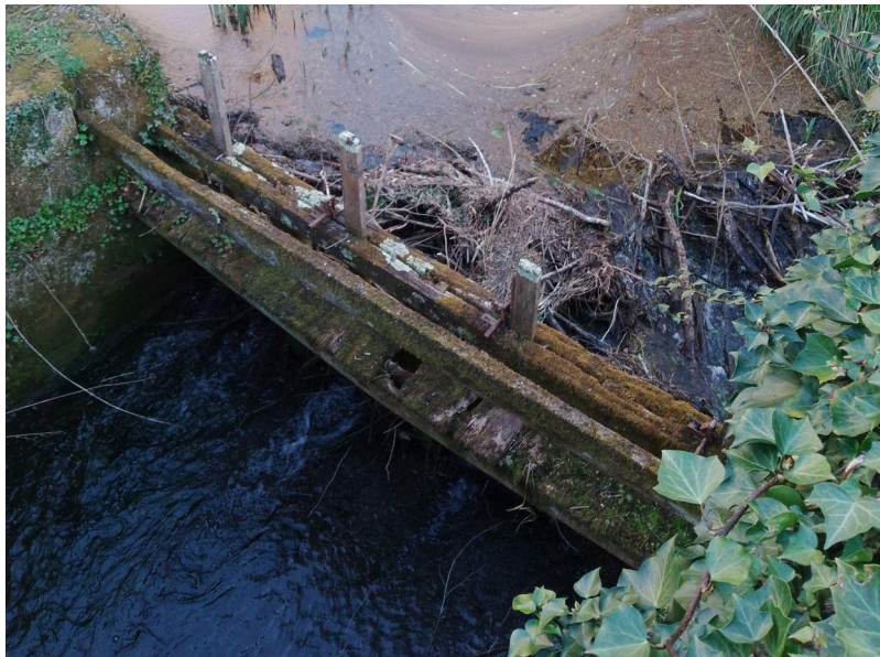
Photo Barrage de la vanne 30/03/2025
