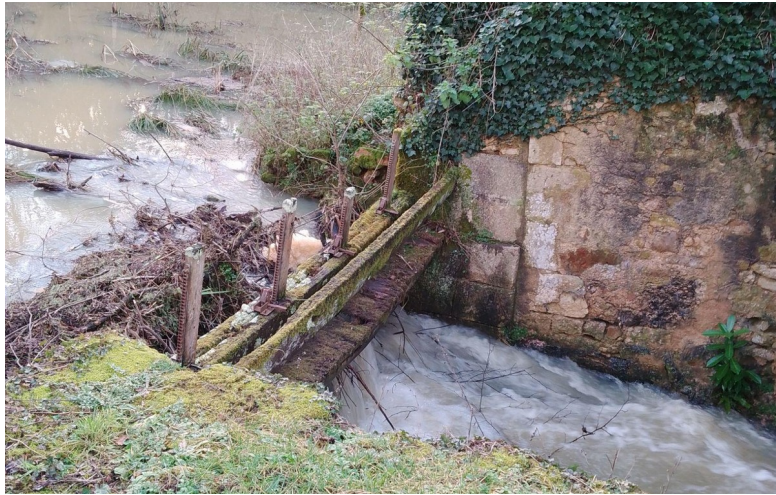
Barrage en appui des vannages le 11/01/2025
