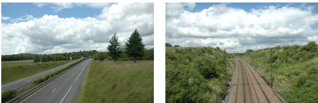
Figure 28. Infrastructures linéaires de transports. À gauche : N10 ; à droite : Voie ferrée (Sources : Symbiose Environnement)
