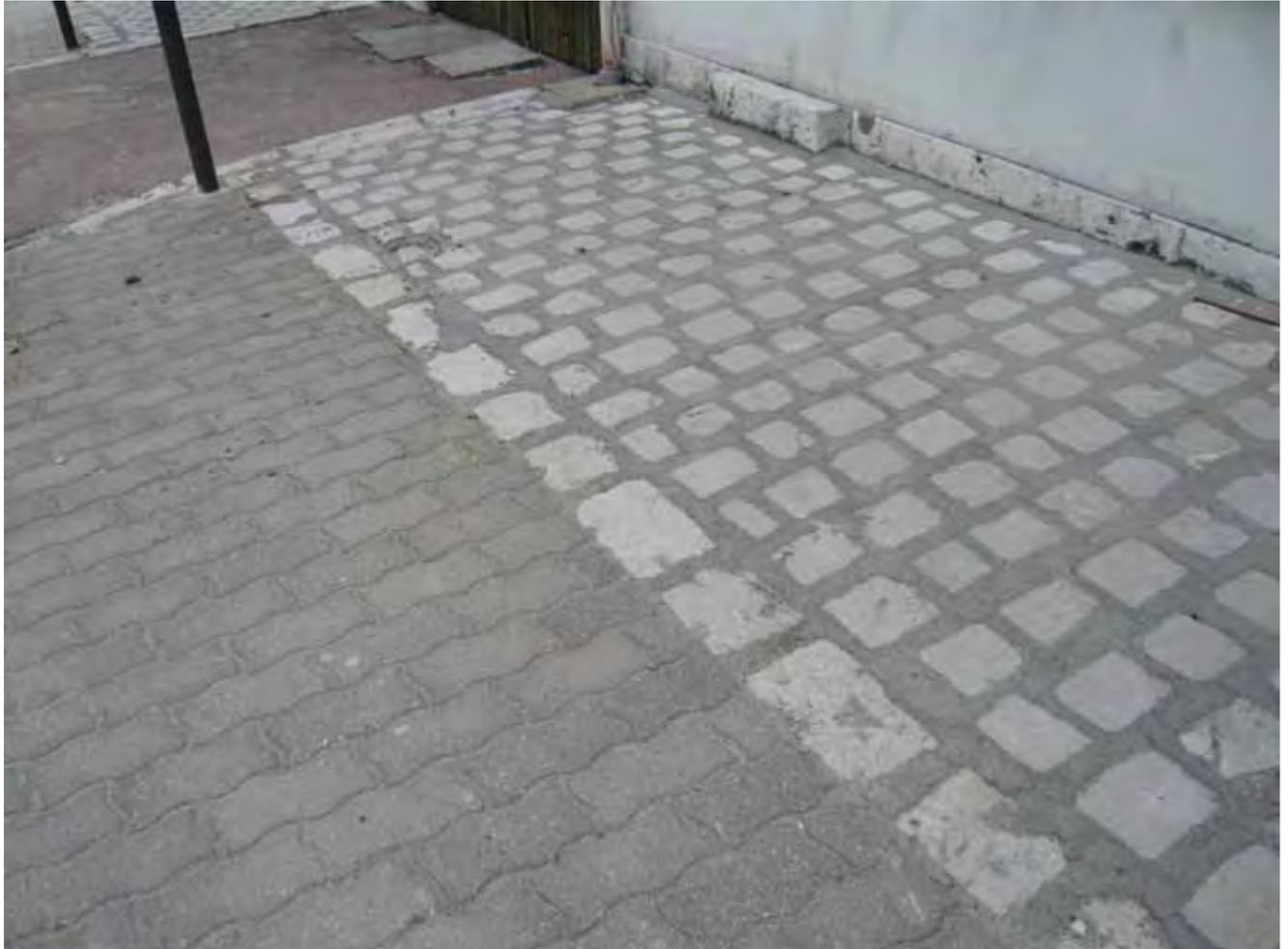
*Les pavés béton sont prohibés ; La pose des pavés de pierre doit être réalisée en réduisant au mieux la largeur des joints.*
