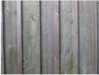
Lorsqu'on fait appel à du bardage de bois, celui-ci doit être positionné verticalement et non pas horizontalement.
