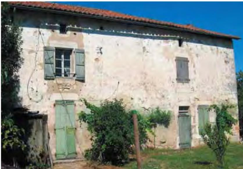
FACADE EN MOELLONS ENDUITE A LA CHAUX ET BADIGEONNEE, AVEC LES ENCADREMENTS DES OUVERTURES ET LES CHAINES D'ANGLE EN PIERRE DE TAILLE
