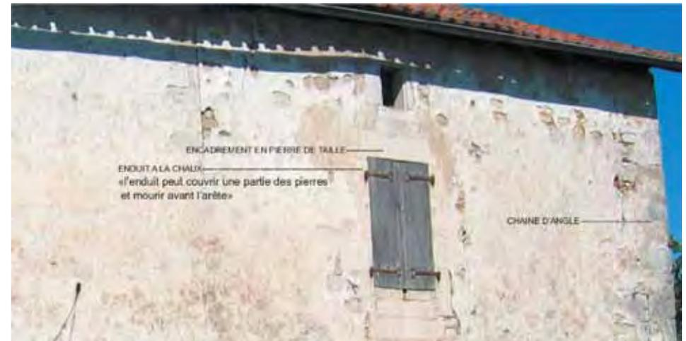
FACADE EN MOELLONS ENDUITE A LA CHAUX ET BADIGEONNEE, AVEC LES ENCADREMENTS DES OUVERTURES ET LES CHAINES D'ANGLE EN PIERRE DE TAILLE
