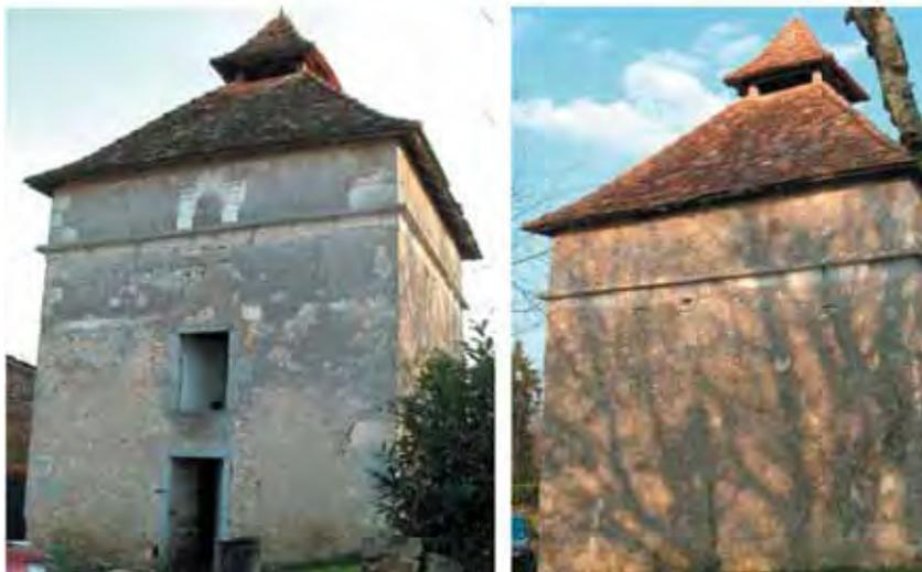
FACADES EN MOELLONS ENDUITE A LA CHAUX, AVEC LES ENCADREMENTS DES OUVERTURES EN PIERRE DE TAILLE ET EN BOIS, LES CHAINES D'ANGLE EN PIERRE DE TAILLE
