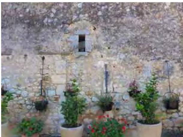
*Le dépouillement d'un enduit peut faire apparaître « l'archéologie de la façade »; dans ce cas, il convient d'examiner, avec l'architecte des bâtiments de France, la manière de mettre en évidence, ou pas, ces vestiges. Ici, les traces d'anciennes baies.*
