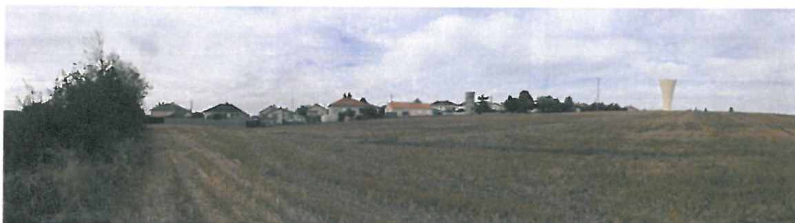
Vue vers le Nord – Vue vers le front bâti du quartier du Moulin à vent – Château d'eau, ligne électrique et transfo marquent le paysage
