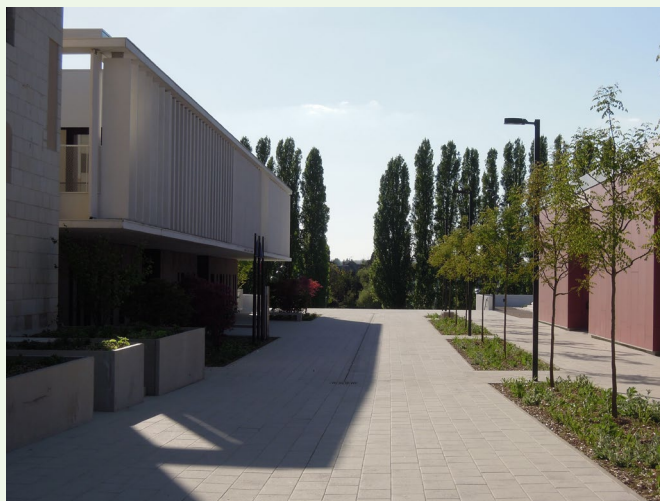
Le groupe scolaire et le cinéma, neufs, desservis par la rue intérieure
