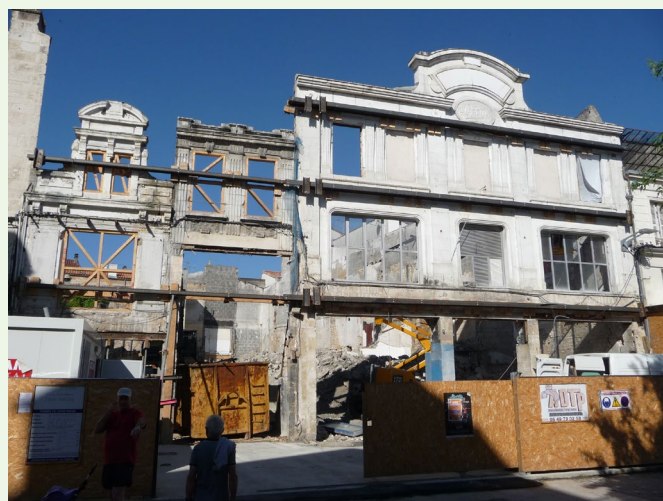
La galerie du Donjon en cours de restructuration (crédit photo Alphaville)
