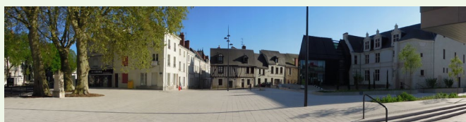
L'hôtel Alaman réhabilité en bureaux et la place Sainte-Catherine réaménagée
