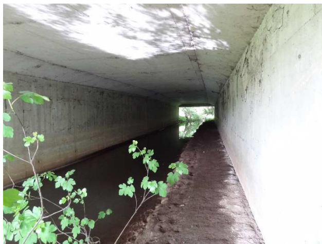
Illustration 14. Banquette émergée aux abords de l'estey de Tartifume dans l'ouvrage hydraulique sous la rocade, source SYSTRA
