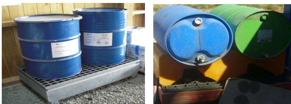
Illustration 63. Produits polluants stockés sur des bacs de rétention, source SYSTRA
