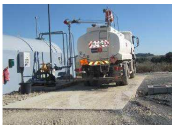
Illustration 61. Exemple de zone étanche pour le ravitaillement des véhicules en carburant, source SYSTRA
