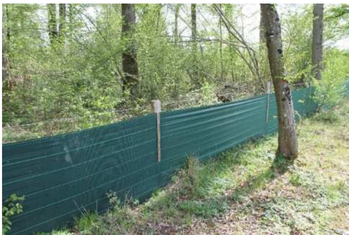
Illustration 54. Barrières à amphibiens à installer en phase chantier, source Systra – 2012
