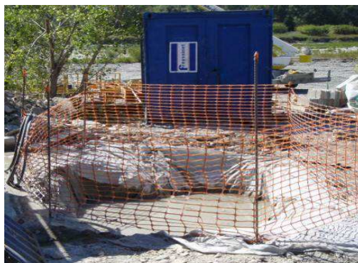
Illustration 64. Exemple de fosse à béton, source SYSTRA
