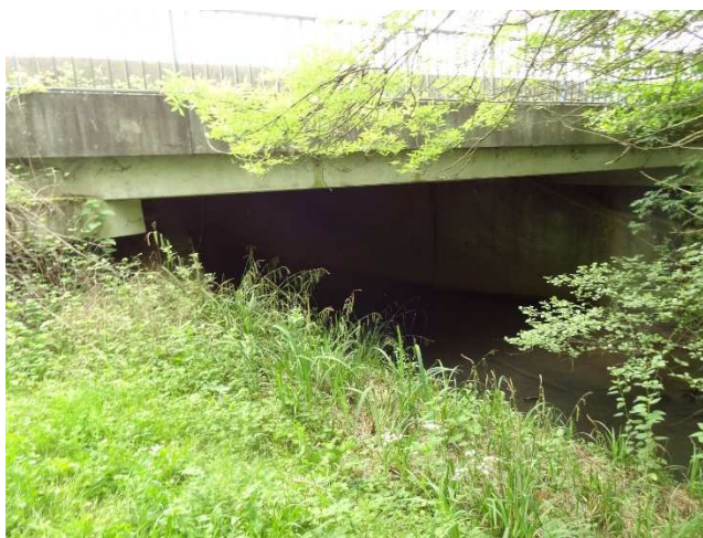
Illustration 31. Ouvrage hydraulique de l'estey de Tartifume permettant la traversée de la rocade à l'est de l'aire d'étude immédiate, source SYSTRA
