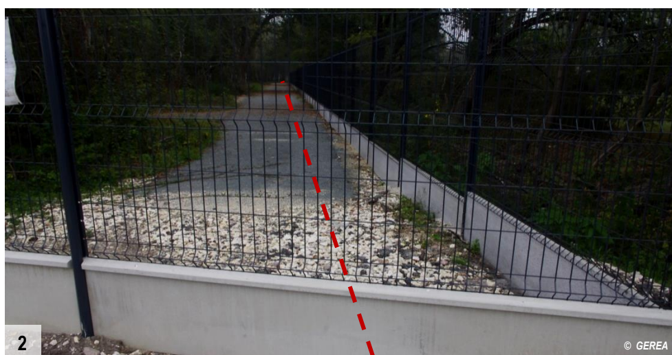
Le projet TIGF longera la clôture installée qui délimitera la partie nord-est du futur site de Dassault Aviation.
