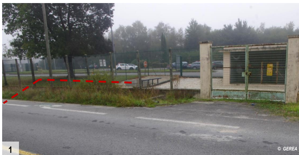
Départ du poste de gaz Est, dans le site de Dassault Aviation, puis traversée de l'avenue déclassée.
