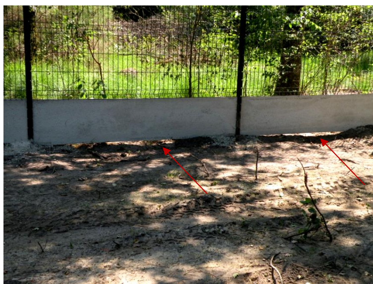
Bordure est du site d'extension où un secteur de la clôture bétonnée n'est pas hermétique, permettant le passage de petits animaux, en particulier d'amphibiens.
