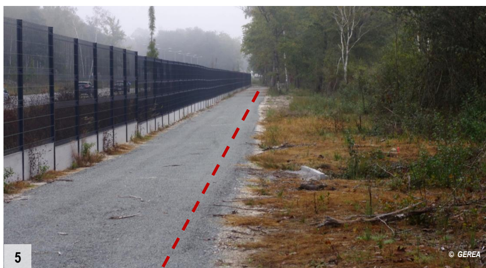
Le projet TIGF continue tout droit, le long de la clôture. La canalisation sera à 2 ou 3 m de la clôture, globalement sur la moitié extérieure du chemin d'entretien actuel.
