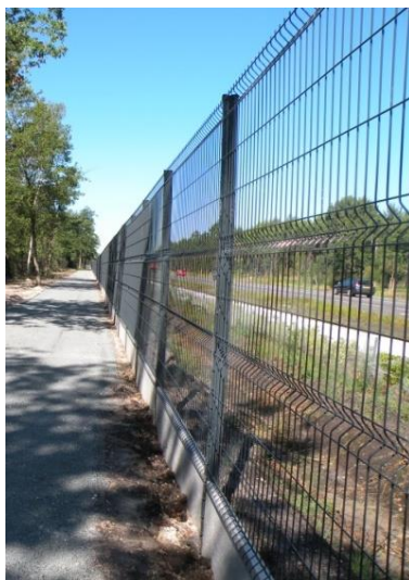
Clôture périphérique en bordure nord du site d'extension, où le projet TIGF passe.
