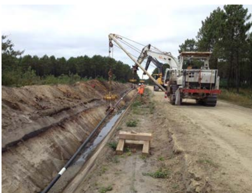
Ouverture de la tranchée et mise en fouille
