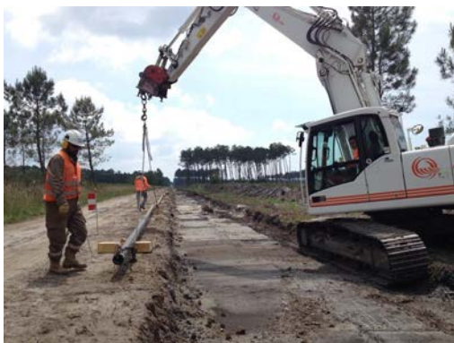
Bardage des tubes, soudures et contrôle des soudures.
