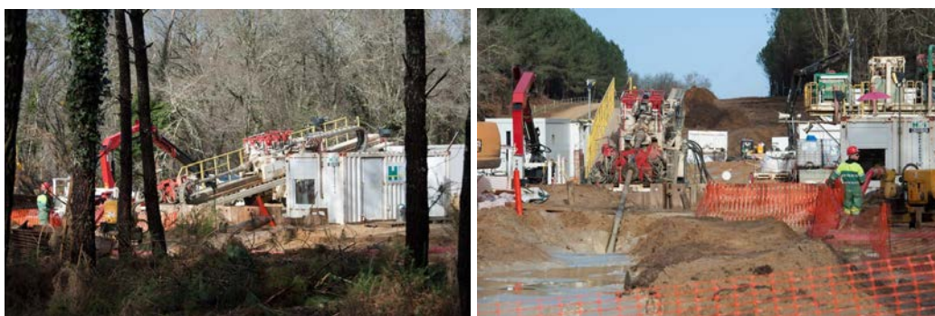
Plateforme de réalisation d'un forage horizontal dirigé (crédit photo : Luc Hautecoeur)
