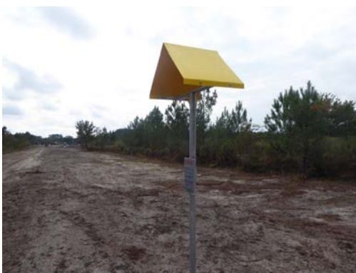
Remise en état et pose de balises pour le repérage et sécurité de la canalisation
