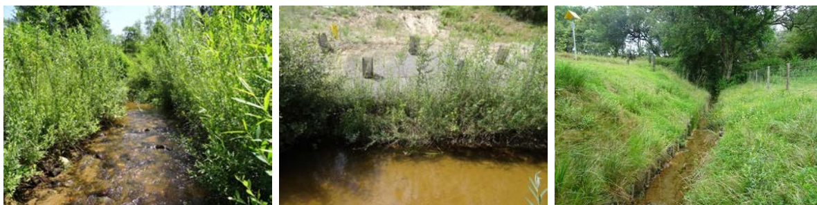
A gauche et au centre : lit de plants de saules (technique de génie végétal). A droite : clayonnage (technique génie mixte)
