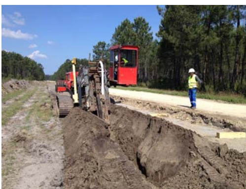
Rabattement localisé de la nappe par aiguille filtrante ou pose d'un drain (temporaire)
