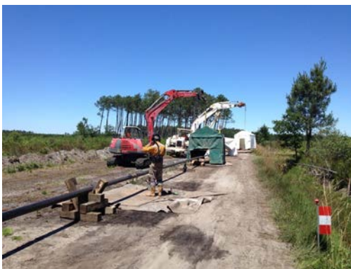
Bardage des tubes, soudures et contrôle des soudures.
