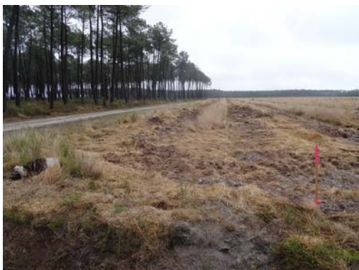
Piquetage de la piste de chantier
