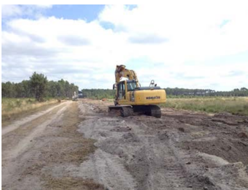
Remblaiement avec pose du filet avertisseur
