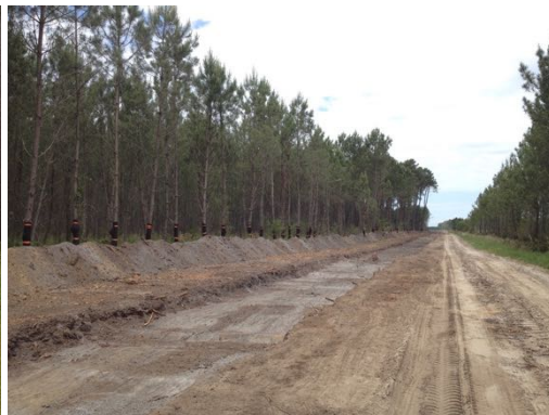
Ouverture de piste avec tri des terres (A droite layon en parallèle de chemin existant)
