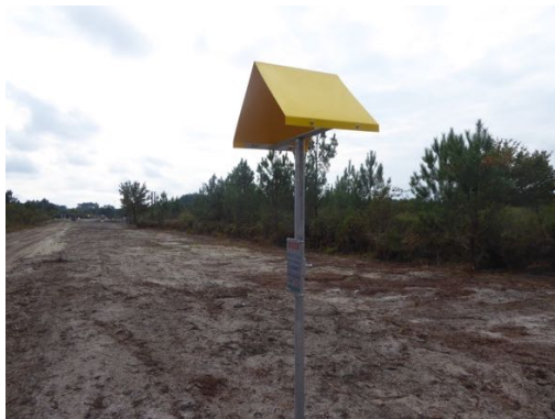
Remise en état et pose de balises pour le repérage et sécurité de la canalisation
