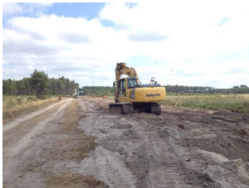
Remblaiement avec pose du filet avertisseur
