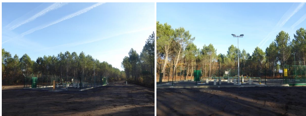
Poste de sectionnement
