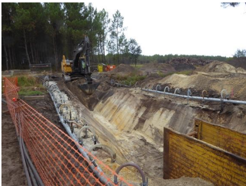
Rabattement localisé de la nappe par aiguille filtrante ou pose d'un drain (temporaire)
