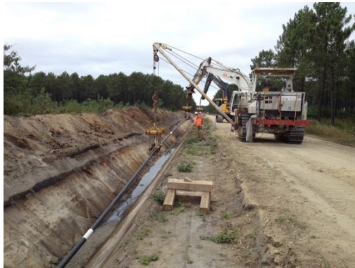
Ouverture de la tranchée et mise en fouille
