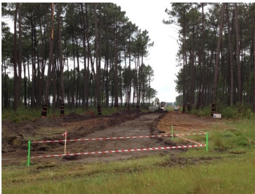
Ouverture de piste avec tri des terres (A droite layon en parallèle de chemin existant)
