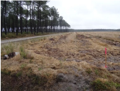
Piquetage de la piste de chantier
