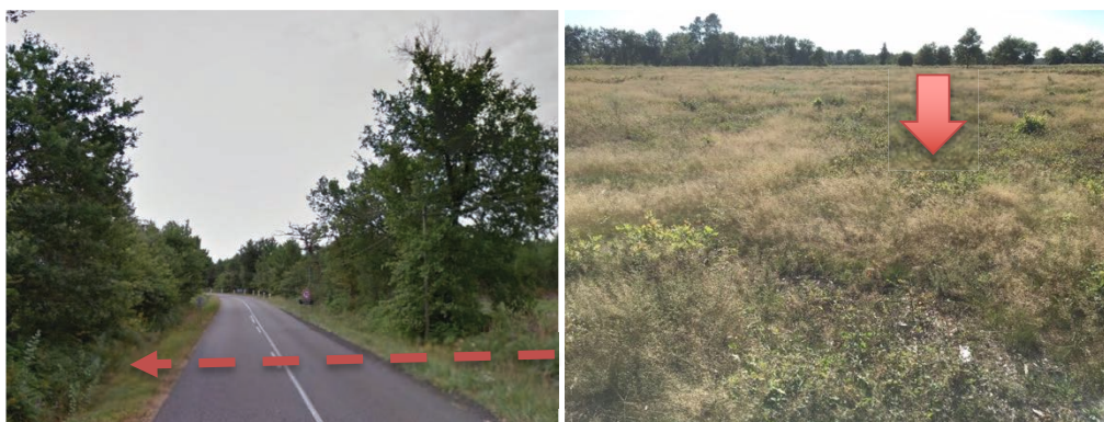
PK 26,5 / Traversée de la route de Tartas RD41, traversée des cultures et emplacement du poste d'interconnexion de RION-DES-LANDES SUD au lieu-dit de Peyrouton (PK27,2).
