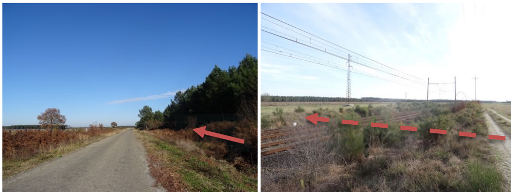
PK 20,4 à 23,4 / Cheminement le long de la piste DFCI (Lesgor) en face du parc photovoltaïque de Langelé (Boos) et traversée des lignes électriques haute tension et de la voie ferrée au lieu-dit Mougnocq (Rion des Landes) PK23,45
