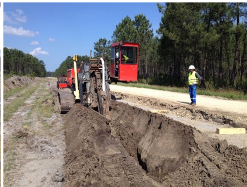
Rabattement localisé de la nappe par aiguille filtrante ou pose d'un drain (temporaire)
