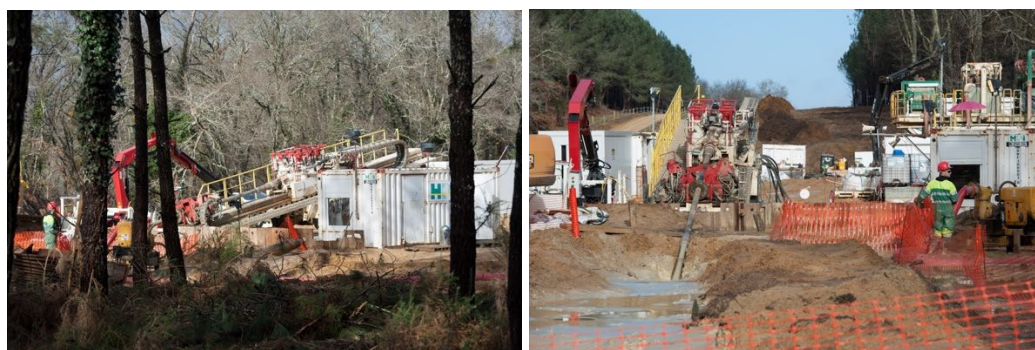
Plateforme de réalisation d'un forage horizontale dirigé (crédit photo : Luc Hautecoeur)
