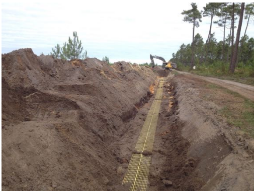
Remblaiement avec pose du filet avertisseur
