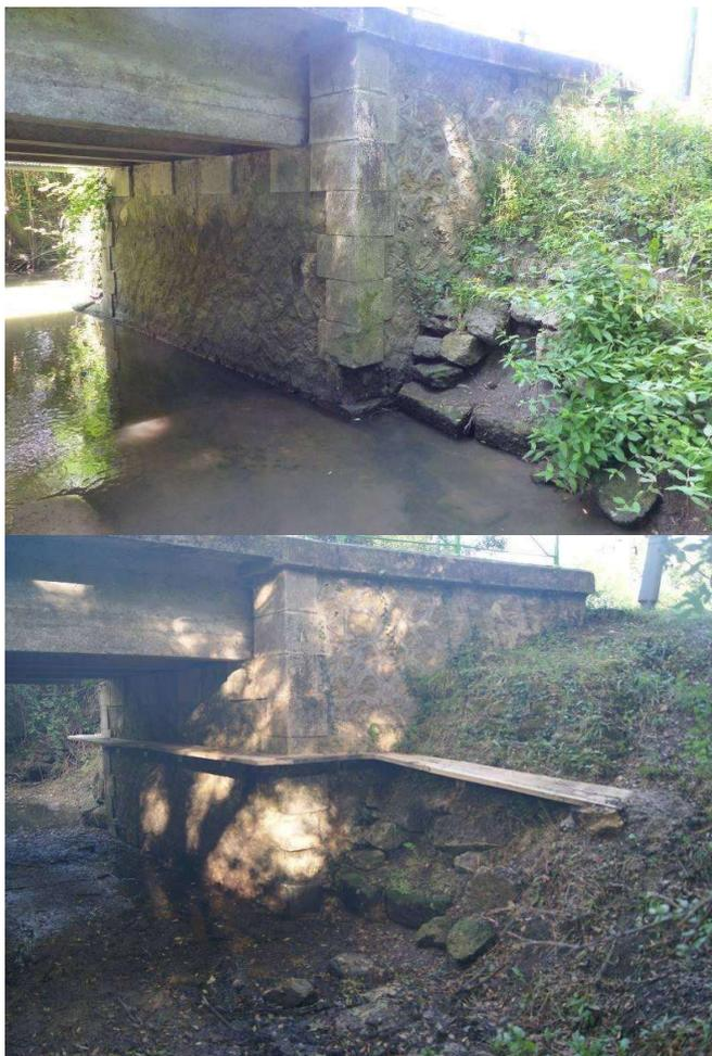
*Photos d'un aménagement d'ouvrage avec un encorbellement (en haut : avant, en bas : après) © CD33*
