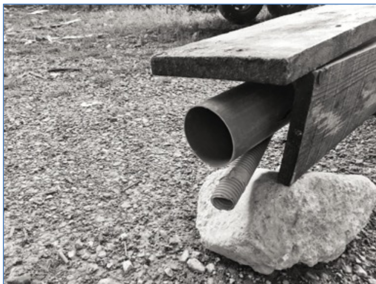
Photo n° 3 : Vue en coupe du coffrage aérien pour la canalisation d'eaux usées
