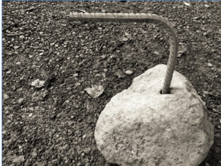
Photo n° 4 : Fixation pour le coffre de la canalisation
