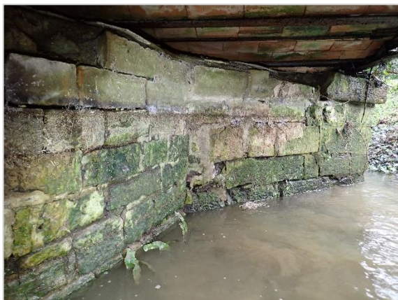
Figure 4. Mur de soutènement avec de nombreux interstices
