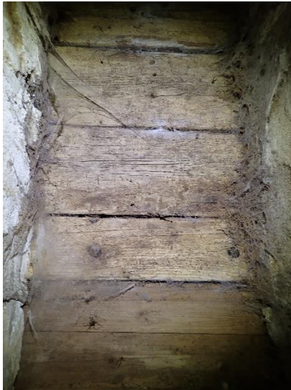
Figure 6. Couverture en bois du canal de gauche.
