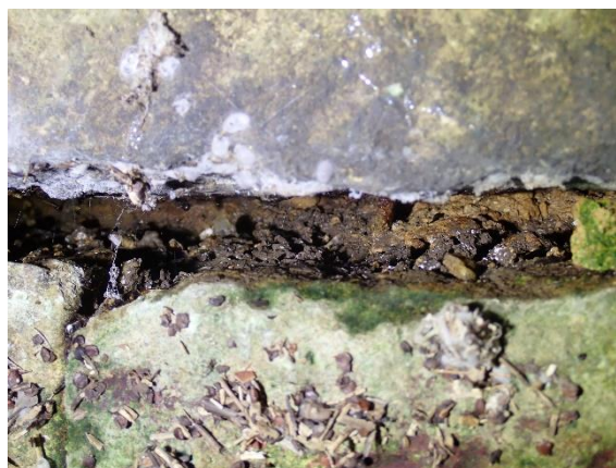
Figure 2. Aperçu de l'intérieur d'un disjoints des murs de soutènement de la zone amont
