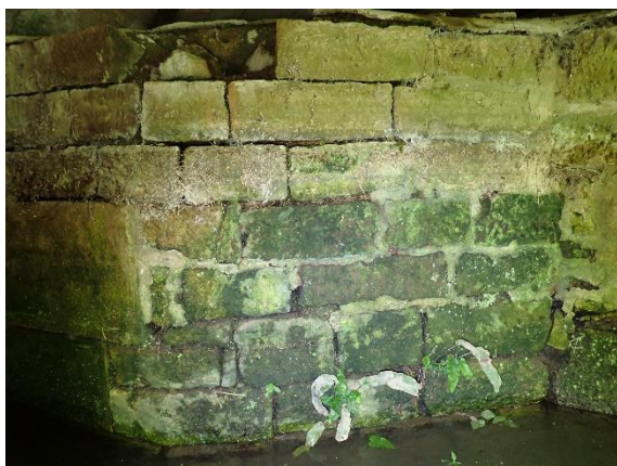
Figure 1. Mur de soutènement de la partie amont avec de nombreux interstices
